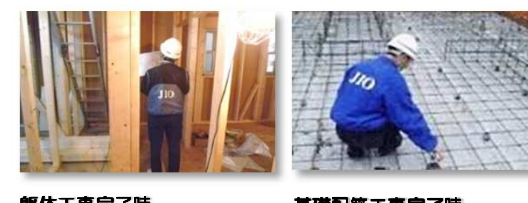
躯体工事完了時
